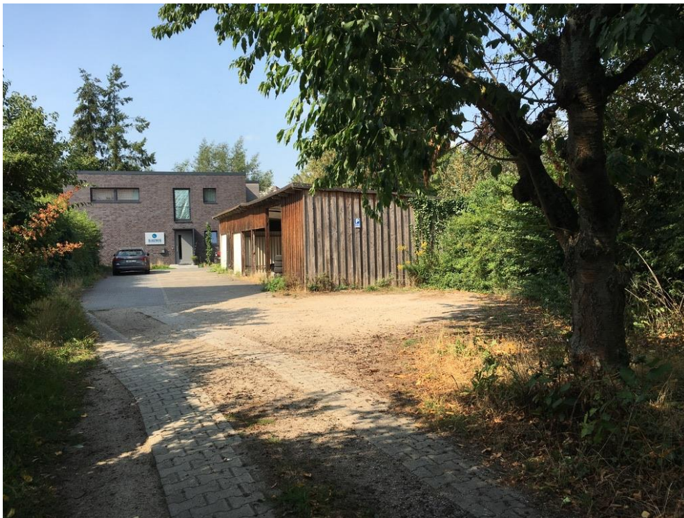
Foto: E. Hett, August 2018, Istzustand Nebengebäude (rechts)
