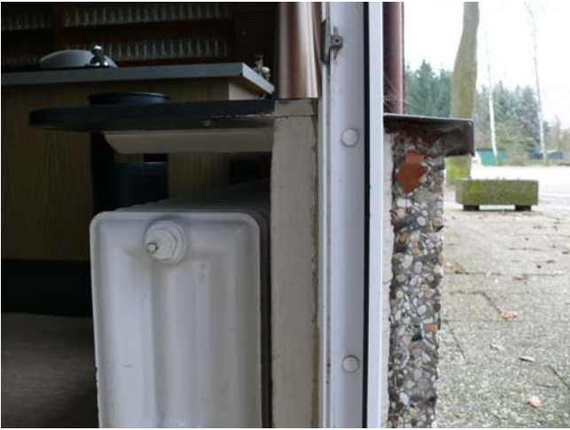
Fensterbrüstung mit Heizkörper
