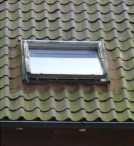
Dachflächenfenster mit provisorischem Eindeckrahmen
