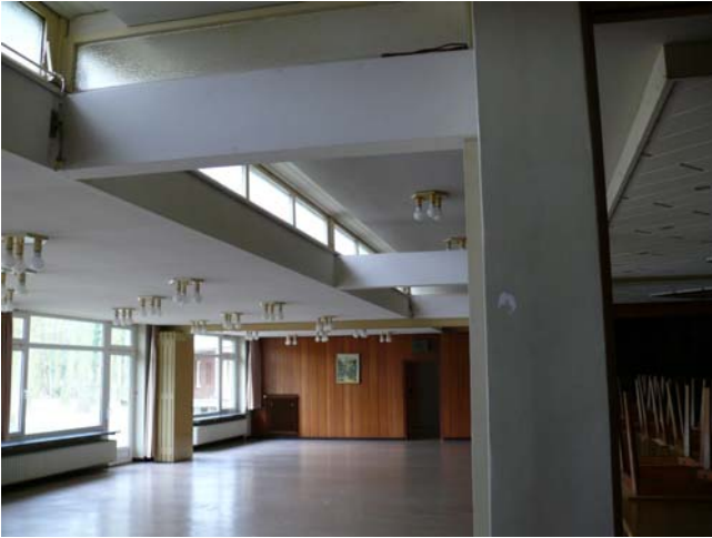
Saalerweiterung mit Oberlicht
