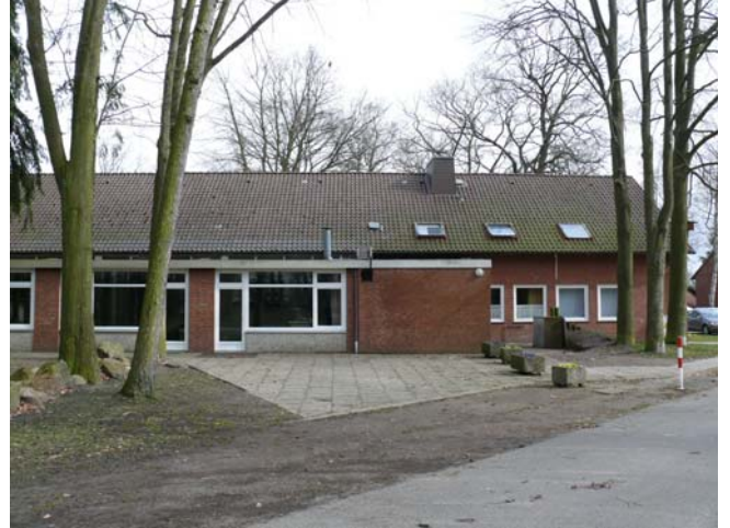
Saalerweiterung mit Fensterbrüstung aus Stahlbeton
