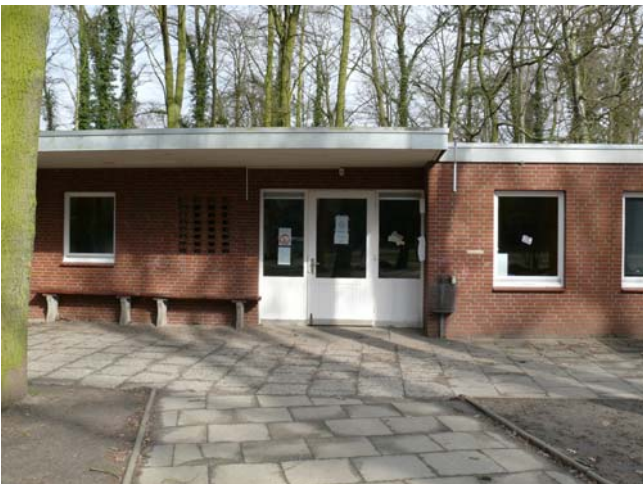
Eingang Jugendzentrum mit auskragendem Vordach aus Stahlbeton
