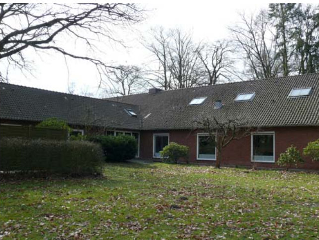
Gebäudeansicht von der Fehlstraße
