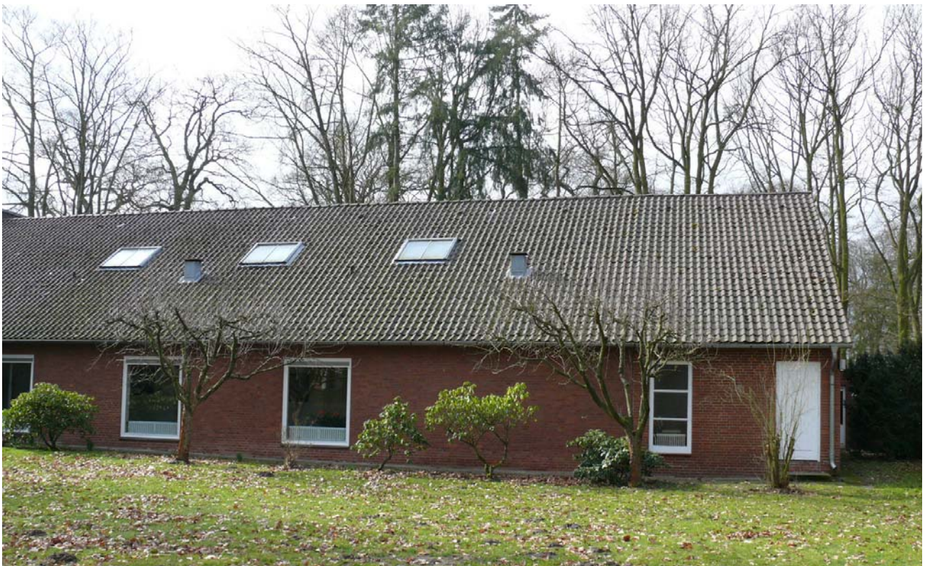
Ablufthauben im Dach über dem Saalbereich
